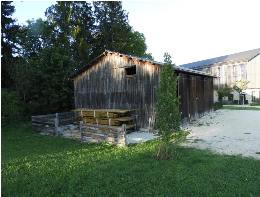
Abb. 4: Die bestehende Scheune von Südwesten
