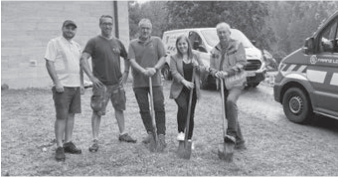
Spatenstich mit Vertretern der Firma Lohr, Herr Ruf (Wasserwärter), Frau Schrode (Kämmerin) und Herr Schnetzler (Ingenieur)
